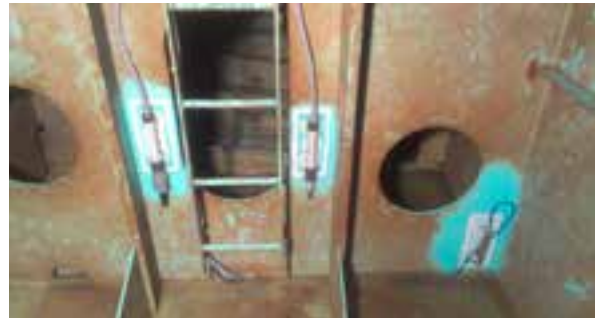
Prüfen von selbstheilenden Lacken in einem Ballastwassertank mit Sensoren. (Fotos: Zied Ghrairi und IFAM) | Test specimens of self-healing coatings installed inside a ballast water tank. (Image: IFAM and Zied Ghrairi)
