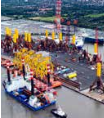
Offshore-Terminal in Bremerhaven (Labradorhafen) mit Tripoden für Offshore-Windenergieanlagen. (Foto: BLG) | Offshore terminal in Bremerhaven (Labrador Harbor) with tripods for offshore wind turbines. (Image: BLG)
