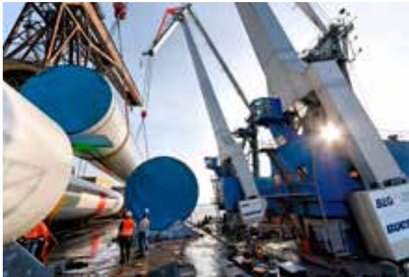
Arbeiten im Hafen, hier unter anderem das Verladen von Turmsegmenten einer Offshore-Windenergieanlage. (Fotos: BLG) | Work in the port, here including the loading of tower segments of an offshore wind turbine. (Images: BLG)
