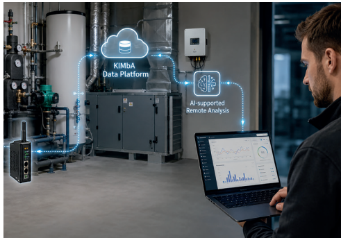
Links: Konzept der KIMbA-Plattform mit Modbus-Anbindung, Datenplattform und KI-gestützter Fernanalyse | Oben: KI-basierte Interpretation herstellerspezifischer Modbus-Register aus Dokumentation und Betriebsdaten | Quellen: BIBA, KI-generierte Illustration
