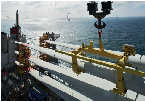
Links: Installation eines Rotorsterns, Foto: Hochtief Oben: Verladung von Rotorblättern, Foto: Senvion
